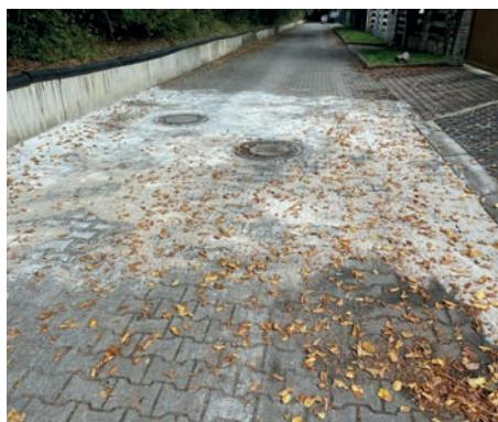
Opravená ulice V Lánech
