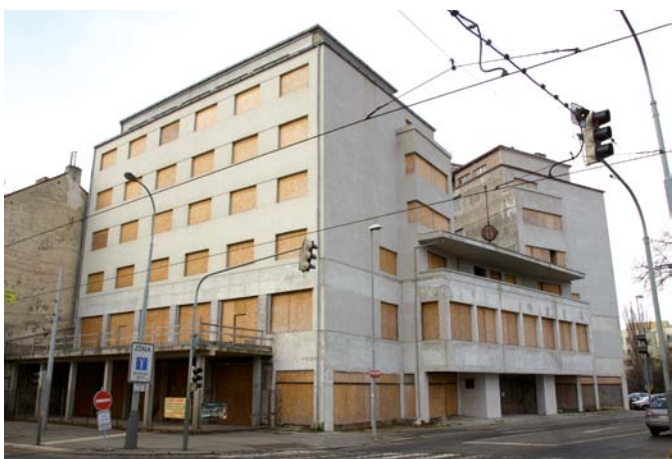
Současný neutěšený stav Paláce Svět
